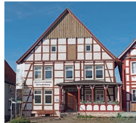
Werkhaus in Schwalenberg, Foto: Landesverband Lippe
